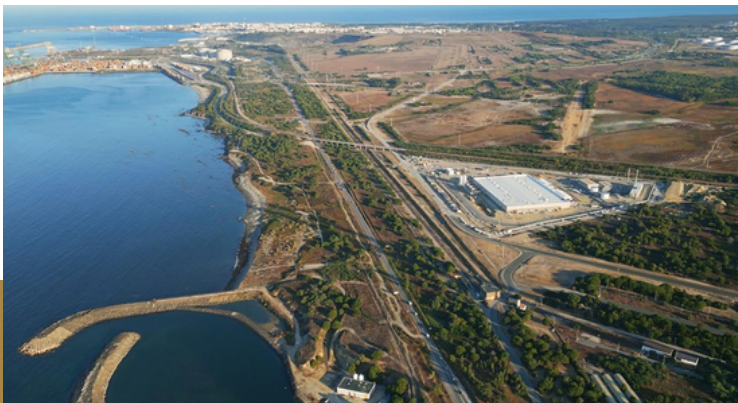
إنجاز أول مبنى ضمن مشروع مجمع مراكز بيانات Sines DC
